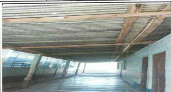
Foto 1: Mantenimiento de balcon y sustitución de corredor aereo por lamina troquelada calibre 26 e instalación de canales y aplicación de pintura.
