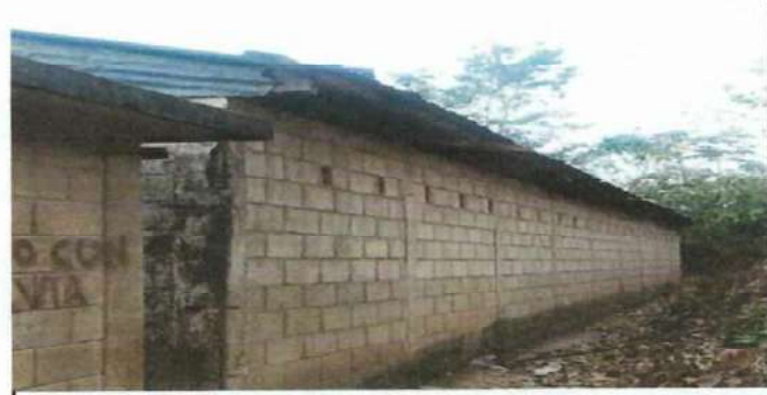
Foto 6: Elevar 3 hiladas de block para muro perimetral.
