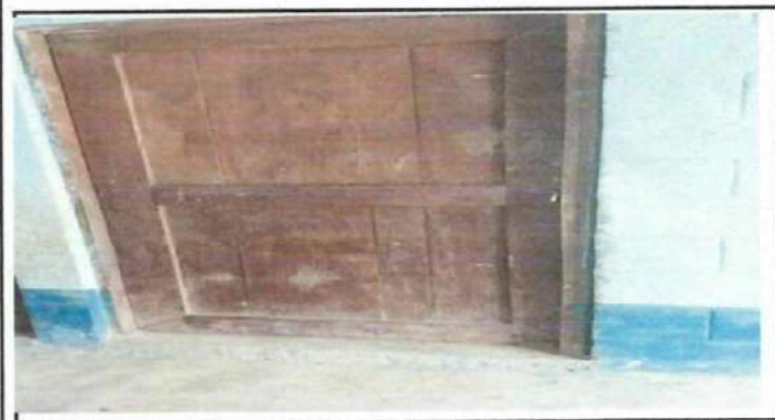
Foto 3: Fabricación de puerta de metal con chapa por puerta de madera.
