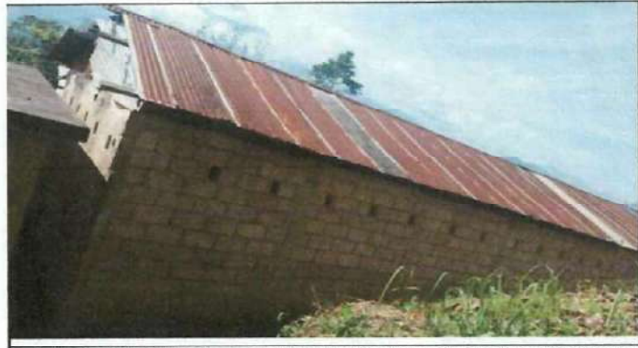
Foto 4: Cambio de lamina normal por lamina troquelada calibre 26 aluzinc
